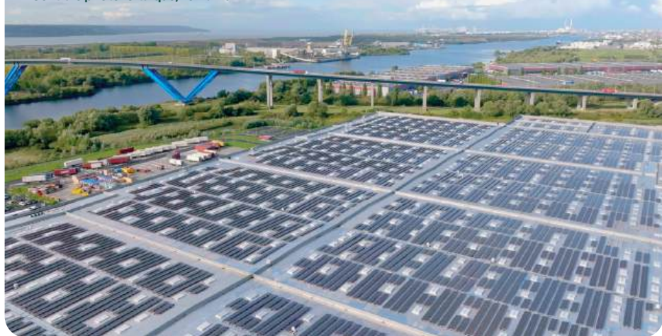
Centrale photovoltaïque, Le Havre
